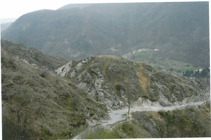
Fig. 2. Il sito visto da Ovest.
